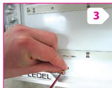
Закрепить светильник 4-мя болтами или саморезами в заранее подготовленные отверстия на потолке или стене
