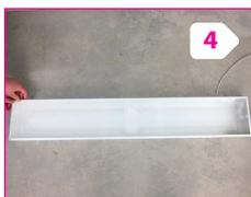
Задвинуть стекло рифлёной поверхностью наружу в светильник и вернуть в прежнее положение боковую поворотную стенку
